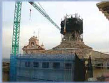
Obras en la Iglesia de la Compañía 2003
